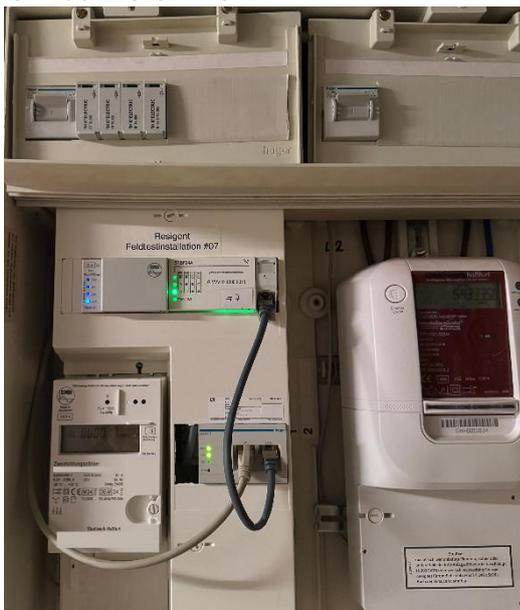
Installierte Komponenten im Zählerschrank: SMGW, Zähler, Steuerbox und EMS
